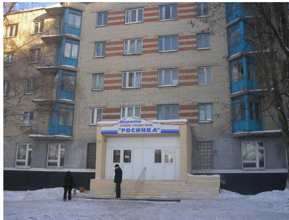
Здание общежития по адресу г.Белгород, ул. Костюкова,13
