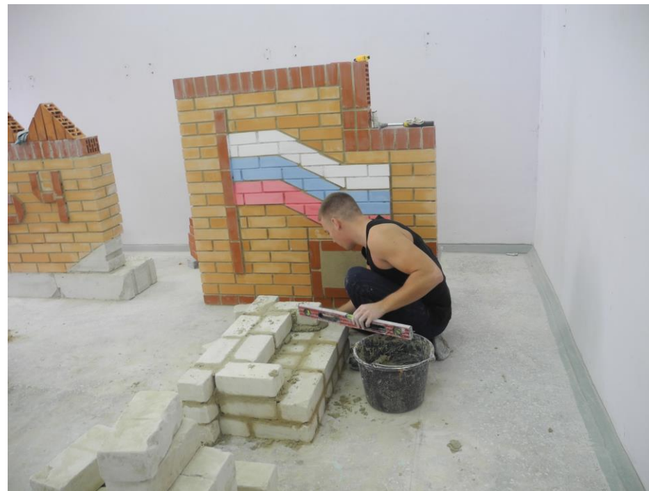
Мастерская каменных работ по адресу г.Белгород, пр. Гражданский, 50
