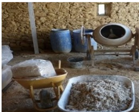
Рисунок 1 - Подготовка компонентов для костробетона
